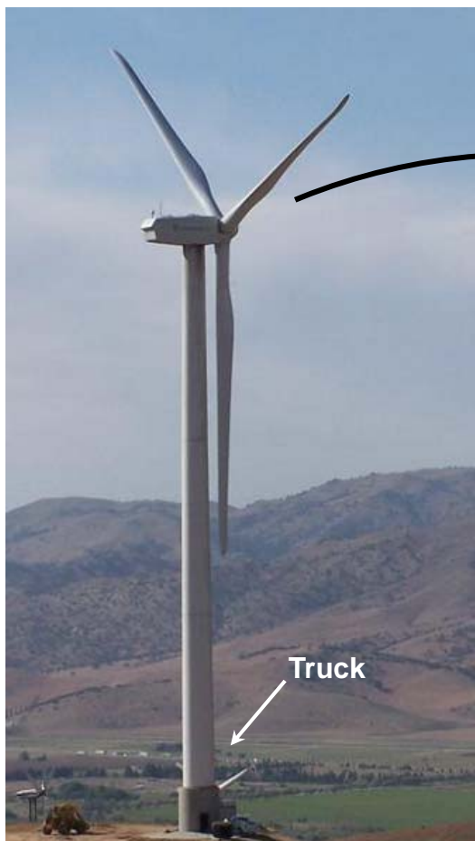
1.5-MW Turbine 40-Meter Blade
